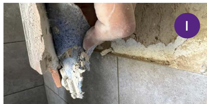
I Controle van de hechting van het waterdichtingsmembraan
