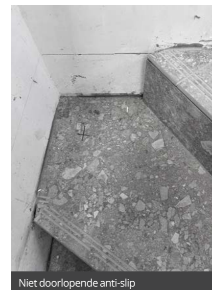
Niet dichtgevoegd
