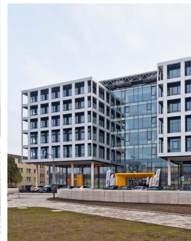
De nieuwe spoedeisende hulp en chirurgie in het ziekenhuis van Pardubice: het paviljoen werd gebouwd als een solitair paviljoen ingebed in de bestaande site aan de zuidelijke rand van Pardubice. Foto: Penta Project.
